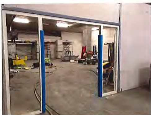
Figuur 4 Plaatsen kozijnen voor binnenruimtes
